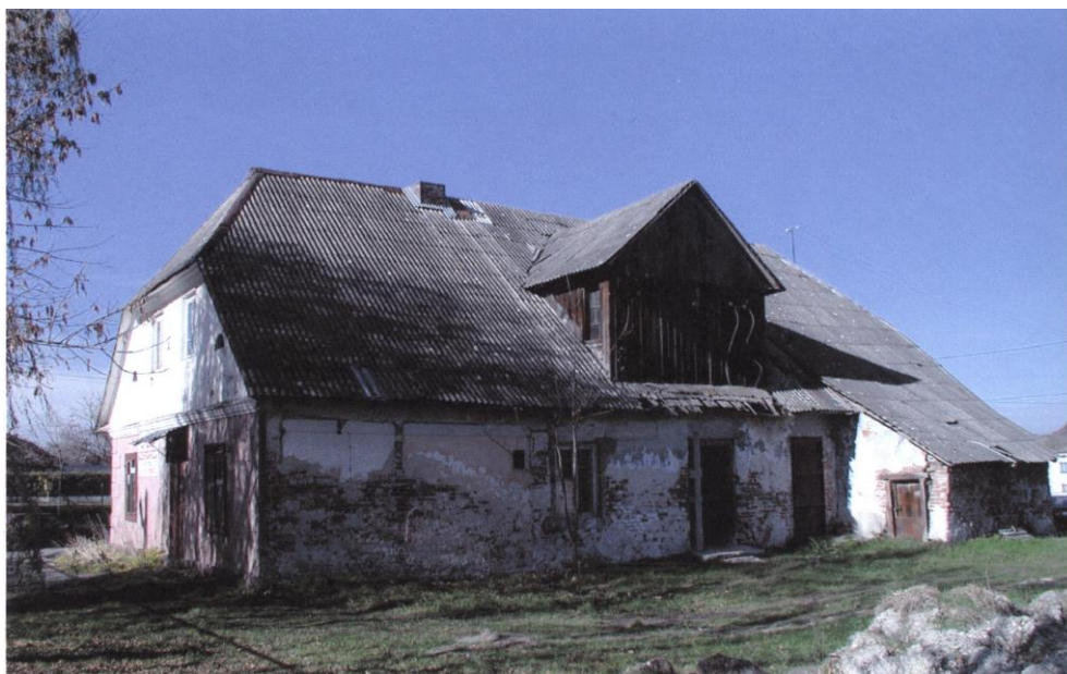
Rys 17 Budynek drewnianego zajazdu widok od strony dziedzińca (stan przed remontem)
