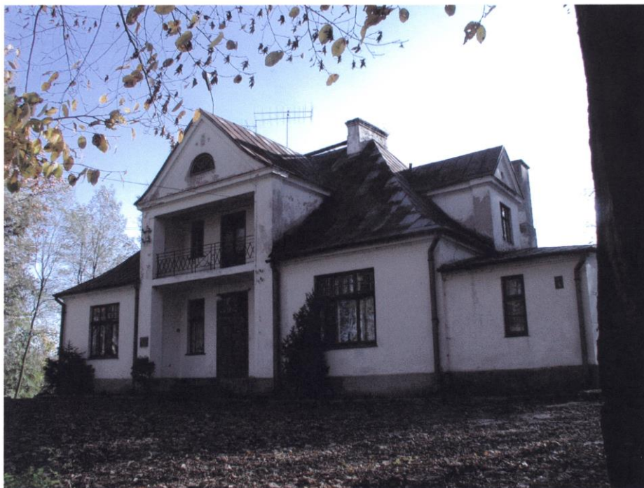
Rys 15 Dom administratora widok od frontu
