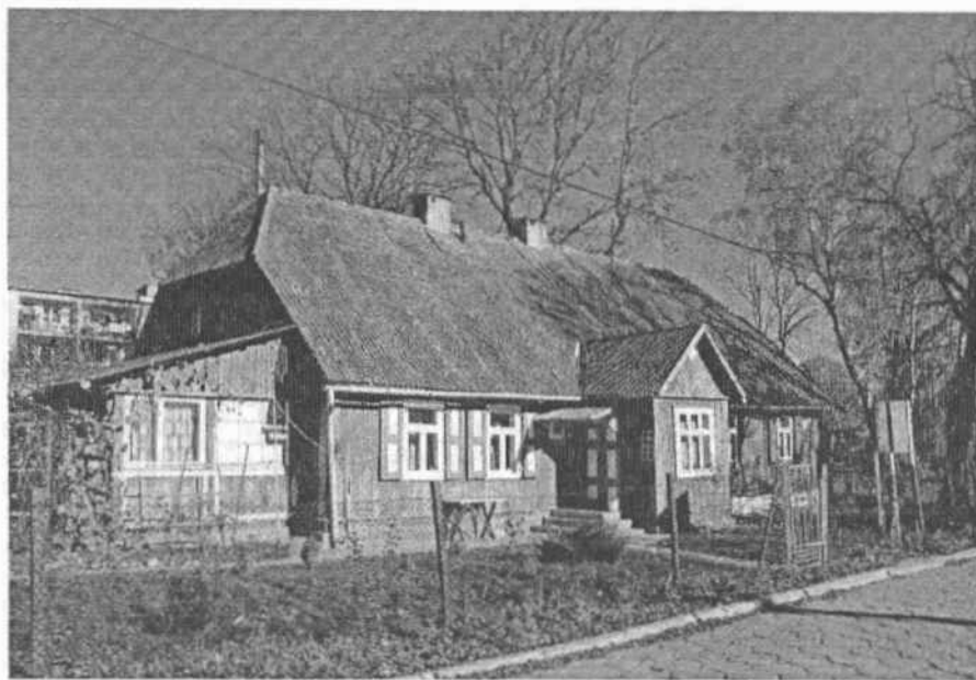
Rys 20 Oficyna dworska w Tarnawatce
