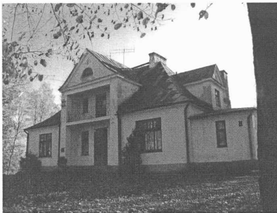
Rys 15 Dom administratora widok od frontu
