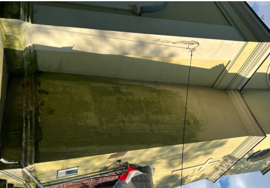
fol.11 Elewacja północna – widoczne wykłty głonów w części wieżowej (ściana pochylona) sięgające ok. 8,00m
