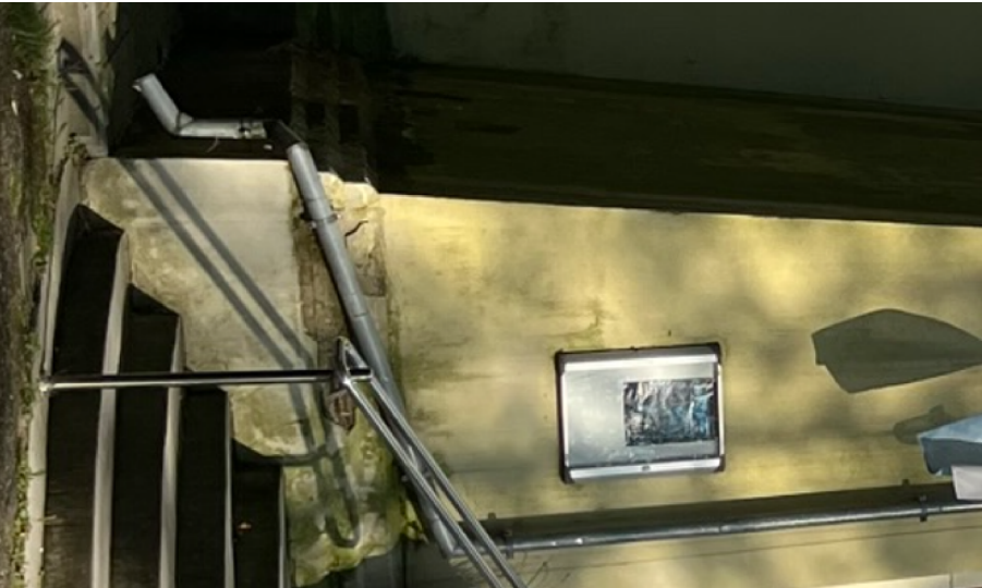
foto.15. Elewacja zachodnia – ubytki cokołu – prowadzenie rury spustowej
