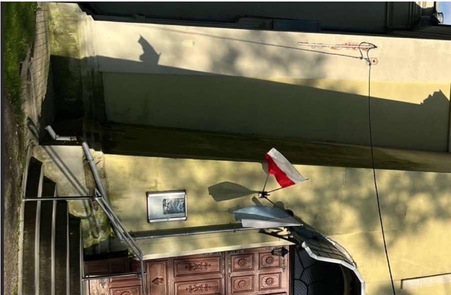
foto.12. Narożnik północno-zachodni – widoczne wykwity glonów w części cokołowej, spełkanie cokołu i schodów
