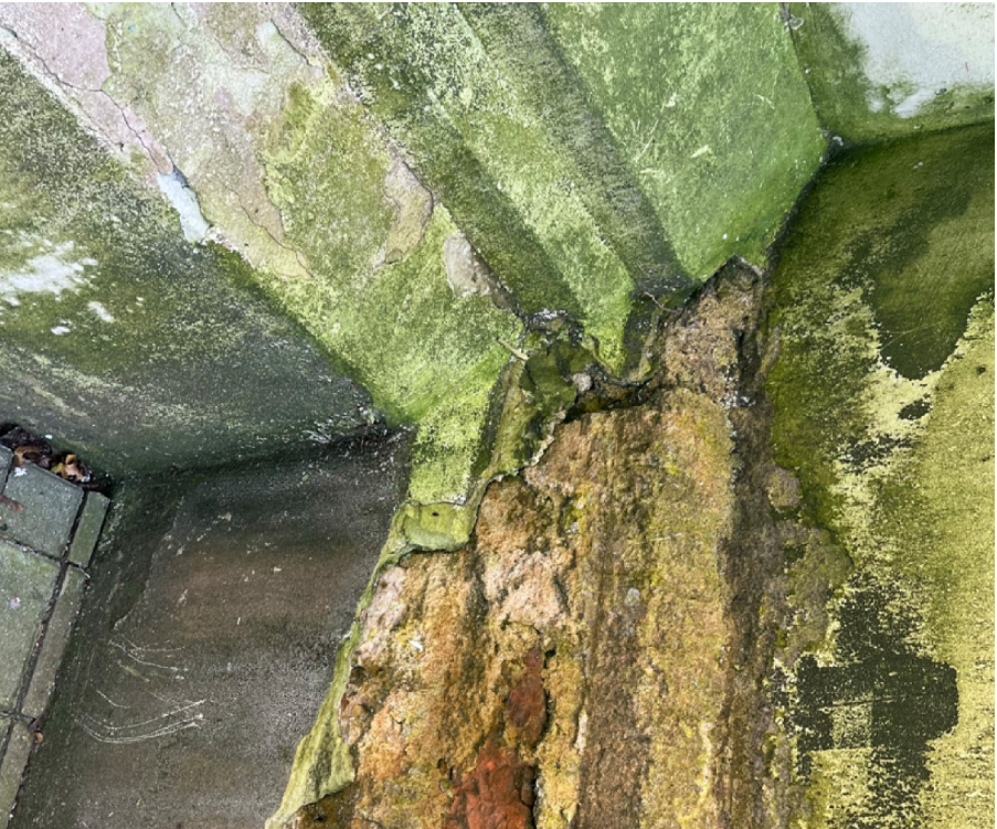
fol.8 Narożnik północno-zachodni – widoczne wykłty głonów w części cokołowej, spękanie cokołu
