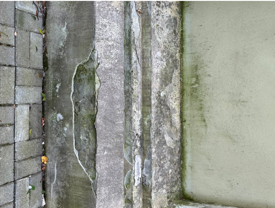
fol.9 Elewacja północna – widoczne wykłty głonów w części cokołowej, spękanie cokołu
