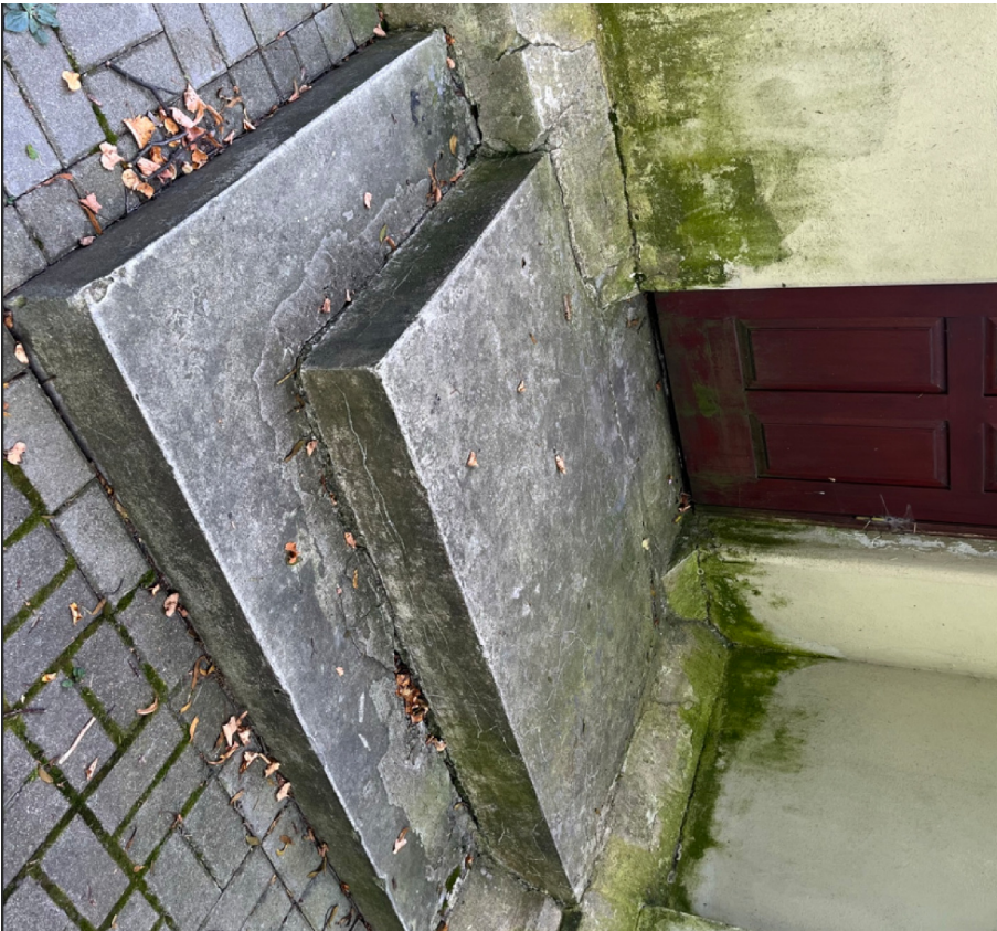
fol.7 Narożnik północno-zachodni – widoczne wykłty głonów w części cokołowej, spękanie cokołu i schodów
