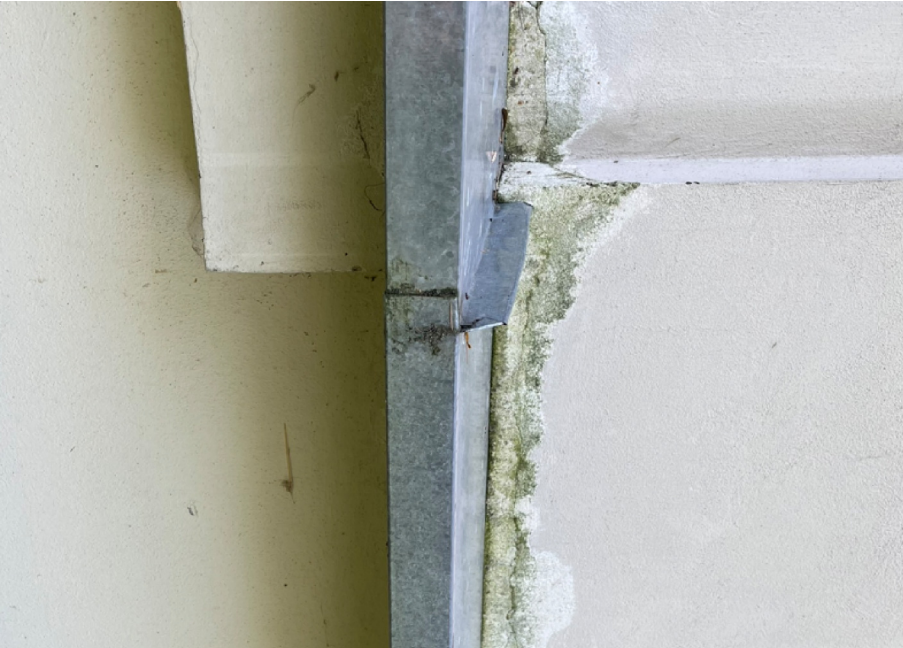
fol.10 Elewacja północna – widoczne zawiłgocenie, spękanie tynku nad parapetem okien
