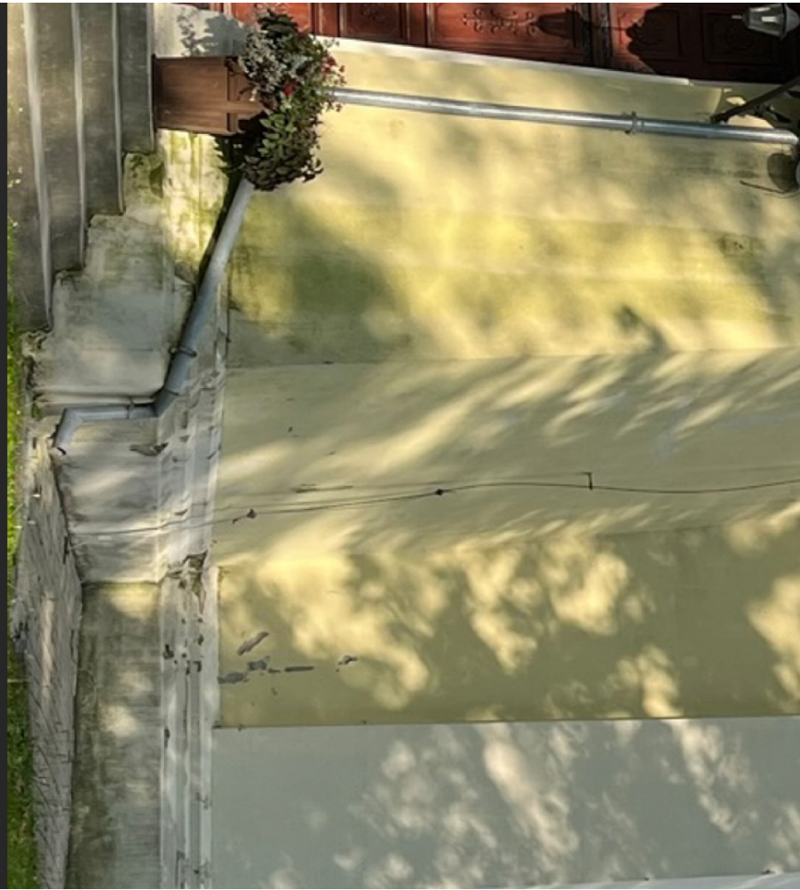
foto.14. Elewacja zachodnia – zawiłocenie muru, widoczne wykwity glony głównie na styku z terenem
